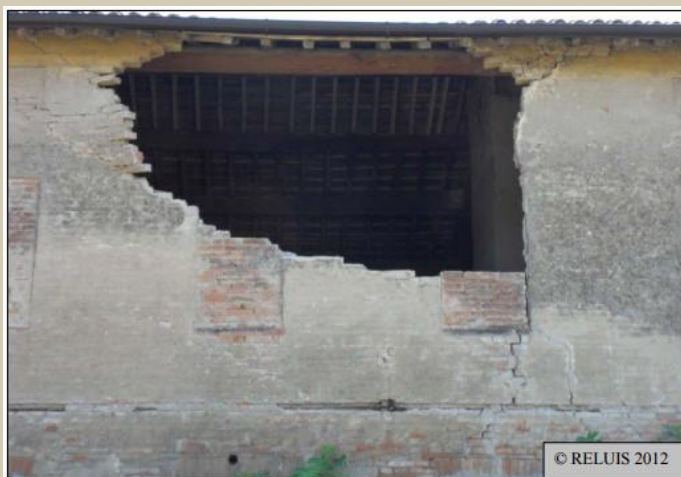
Fig. 4.11 – Meccanismo di sfondamento della parete del timpano (Foto da: MEDEA - Zuccaro, Papa - 2003, DPC)
