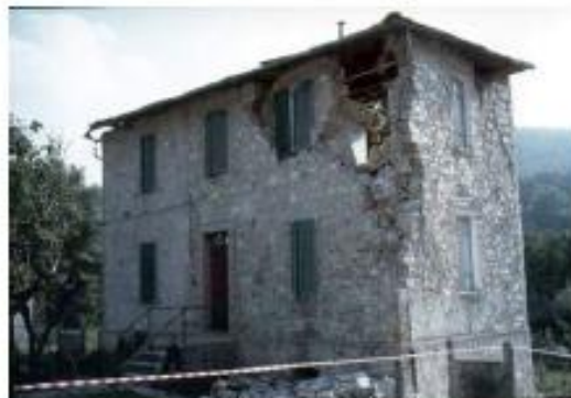
Fig. 1.4 – Meccanismi di ribaltamento composto (Foto da: MEDEA - Zuccaro, Papa - 2003, DPC)
