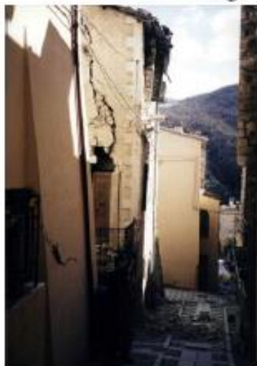
Fig. 1.4 – Meccanismi di ribaltamento composto (Foto da: MEDEA - Zuccaro, Papa - 2003, DPC)
