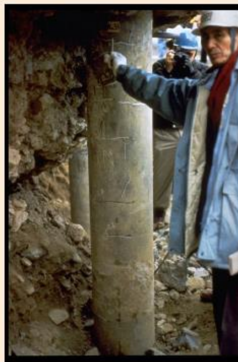
Terremoto di Kobe, 1995: fratture lungo il fusto di pali causate da azioni cinematiche indotte dal sisma
