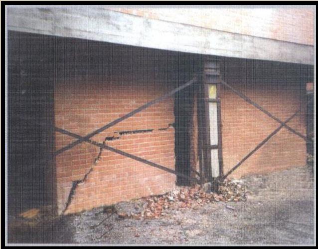
Tamponature non inserite nei telai
